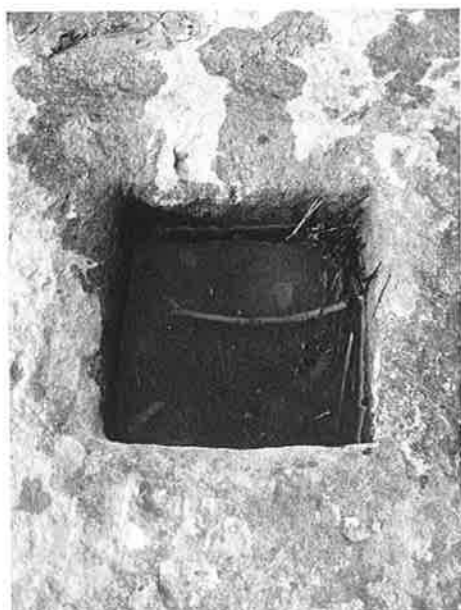
Detall d'un dels forats de pal de la resclosa
