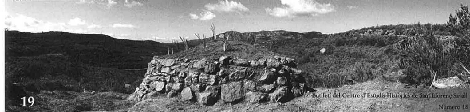
Panoràmica de la barraca 63b del Camí de Salallassera
