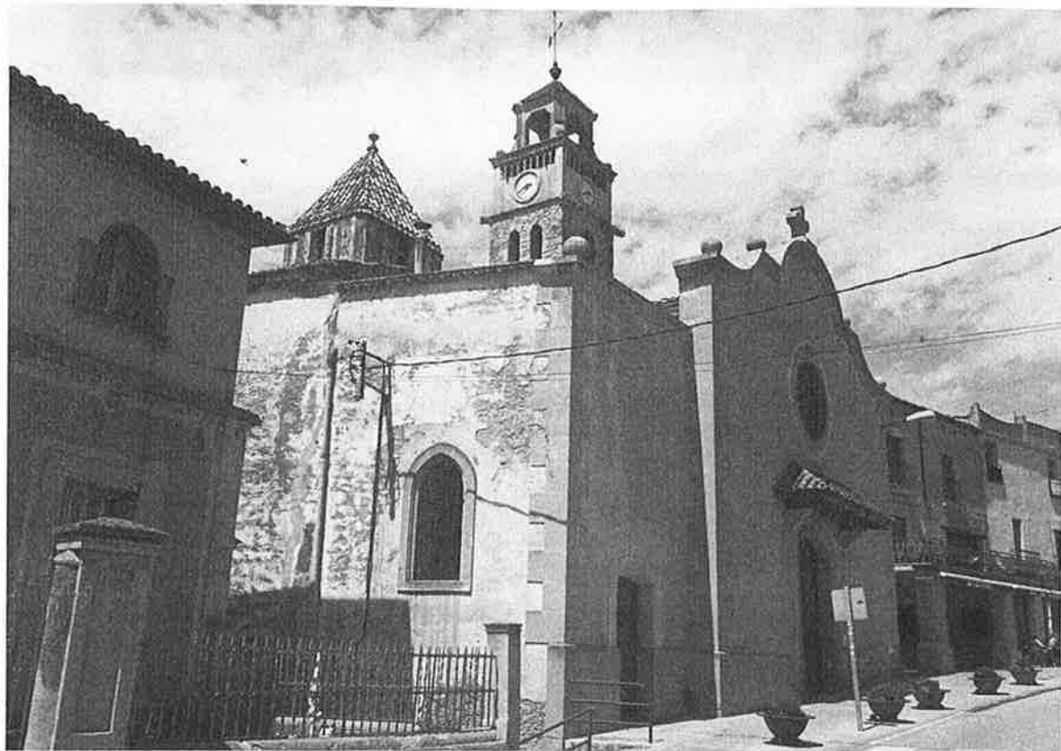
Vista general de l'església de Sant Llorenç Savall amb el comunidor a primer pla i el campanar al darrere.
