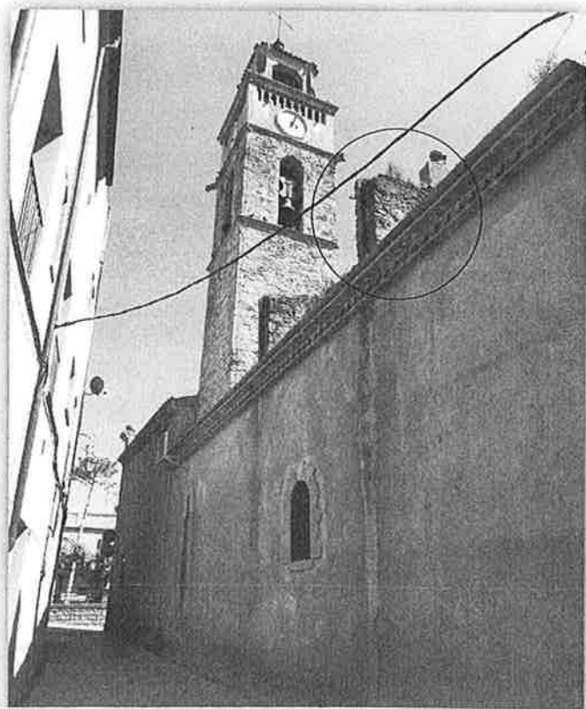
Façana de tramuntana. Hi podem observar a primer terme, sobre la teulada, la part superior dels contraforts, només visibles a aquesta zona. El fet de ser correctament revestit el mur no ens permet fer la lectura de les possibles cronologies.
