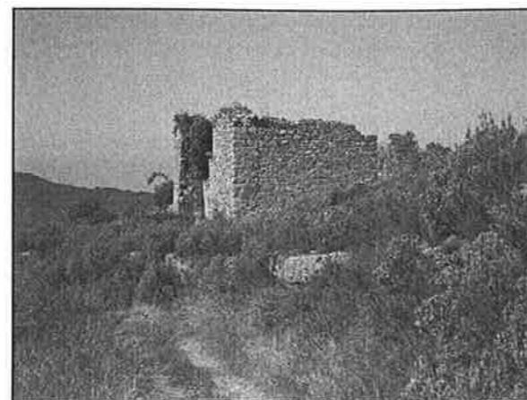
Cal Mesquita avui dia. La casa ha patit un saqueig selectiu, consistent a manllevar les portalades i les llindes de finestres. Això ha comportat l'acceleració del procés d'enrunament de les parets on s'encabien aquestes estructures.
