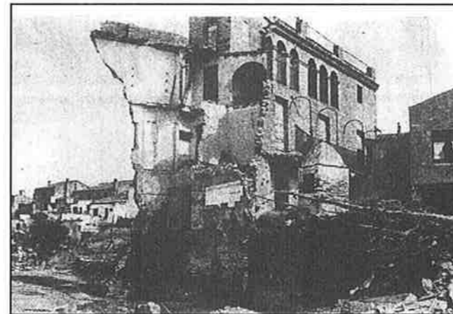
Restes d'un edifici a Rubí derrocat per la riada.
