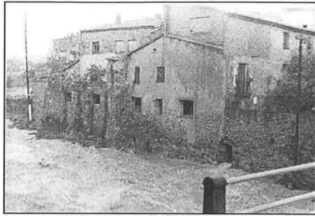
En aquesta fotografia podem apreciar el nivell de les aigües el 26 de setembre, dia posterior als aiguats. A la dreta de la cantonada de la rectoria, podem veure el terrat per on, sota del seu llindar, arribaren a cobrir les aigües, fet que deixà mitja rectoria sota el cabal de les aigües.
