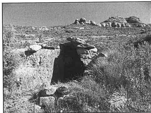
Restes d'una barraca on s'aprecien les diferents filades.
