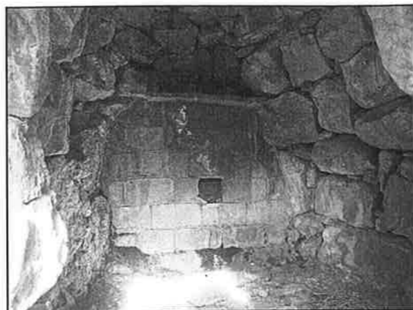
Una barraca amb postada d'obra.
