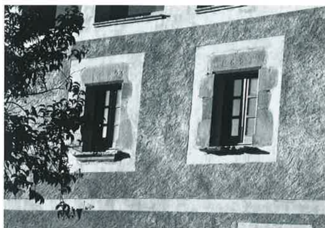
Llindes de la façana est del Marquet de l'Era. Les diferents dates són resultat de les progressives obres de l'edifici.
