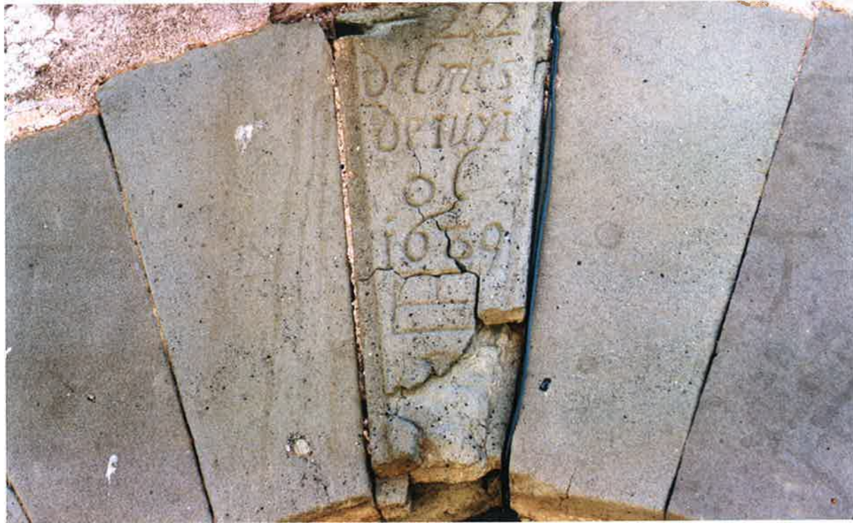
La Serra. Dovella central de l'arc d'entrada a la masia. Per la seva antiguitat i tipologia constituïa tot un petit tresor. Malauradament, el gravat es despreguà parcialment l'any 2007 i només en resta la fotografia. Podia llegir-se: 22 del mes de juliol 1689. A sota apareixia la figura d'una serra.
